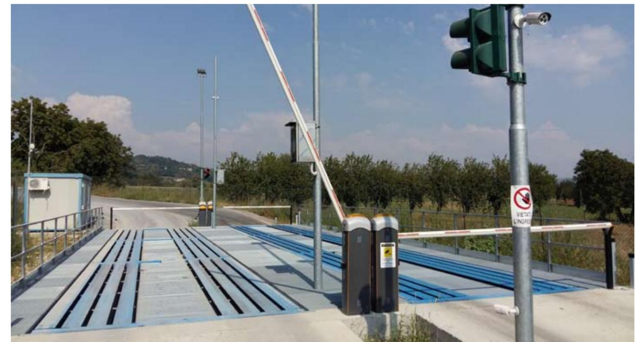
Pesa a ponte connessa a sistema di gestione con controllo merci con software IN/OUT e vari accessori
