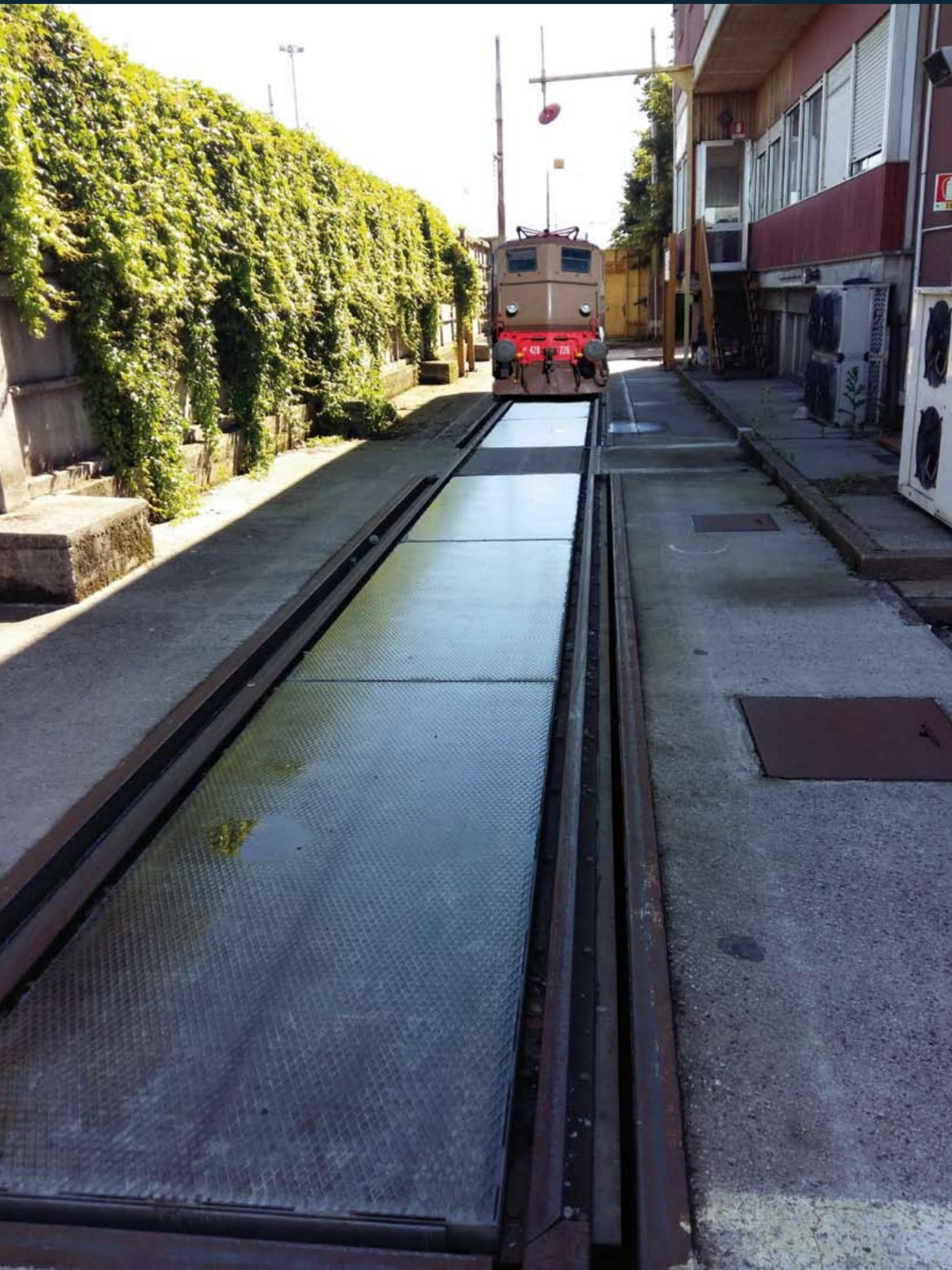
Le pese a ponte **mod. ECAZ** e **mod. EAB** possono essere realizzate in versione stradale, mista stradale o ferroviaria e solo ferroviaria con rotaia incassata o fuori terra. Per il modello **ECAZ** viene creato in cantiere un "cassero" formato da travi HEB e IPE posizionate longitudinalmente e trasversalmente sotto le quali vengono inserite le celle di carico in acciaio INOX con protezione IP68/69.
