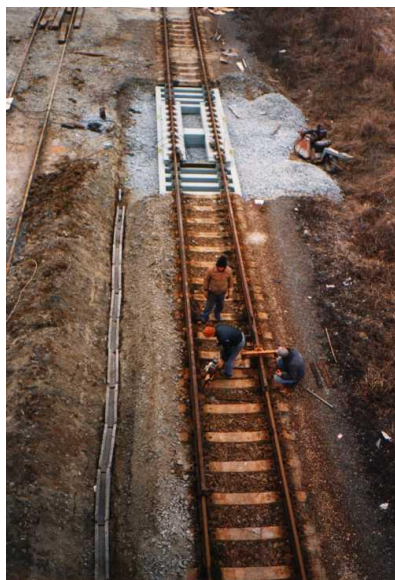
2° gg di installazione
