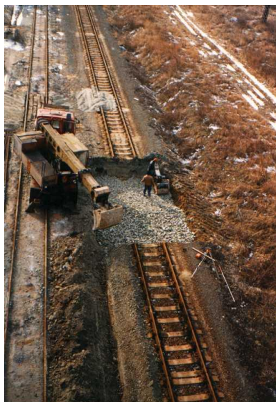
1° gg di installazione
